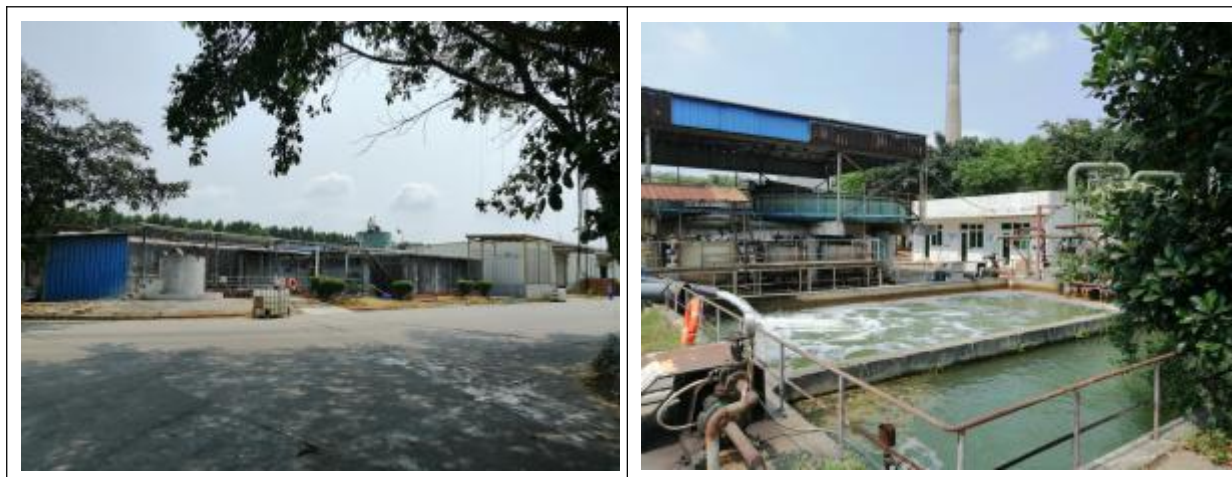
图 2.6-3 现有工程污水处理站现状图
