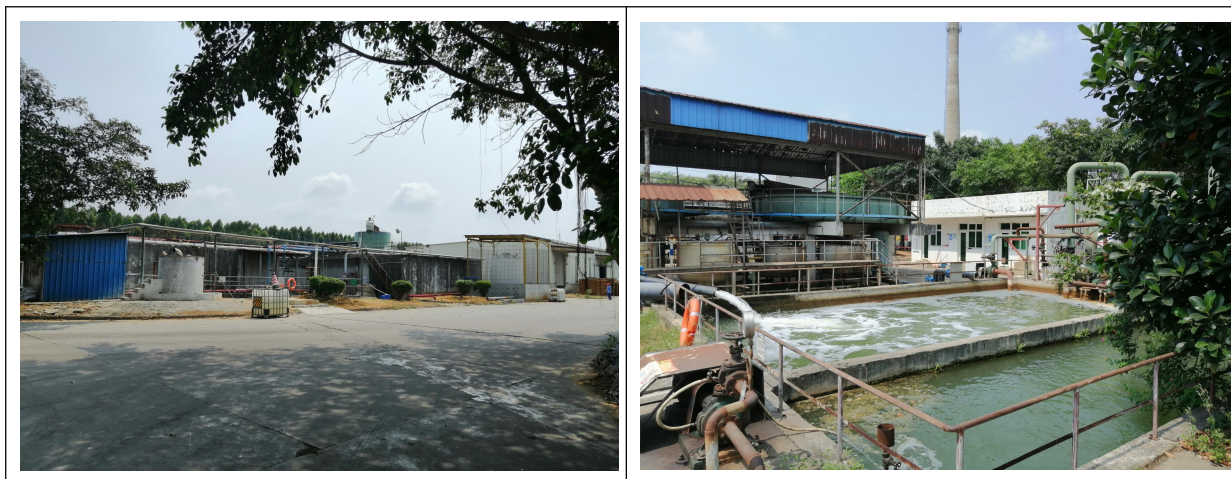
图 2.6-3 现有工程污水处理站现状图
