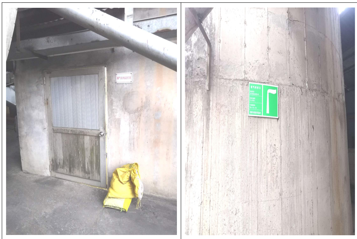
烟气在线监控室
